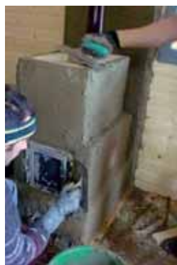
Sequenza di autocostruzione di una piccola «stufa russa» intonacata in terra cruda.
