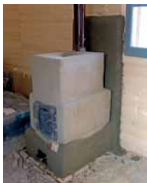
Sequenza di autocostruzione di una piccola «stufa russa» intonacata in terra cruda.
