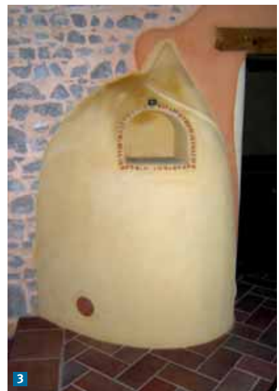
Corpo della stessa stufa con giri di fumo al primo piano.
