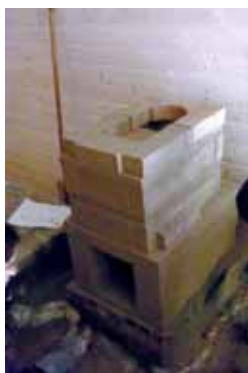
Sequenza di autocostruzione di una piccola «stufa russa» intonacata in terra cruda.
