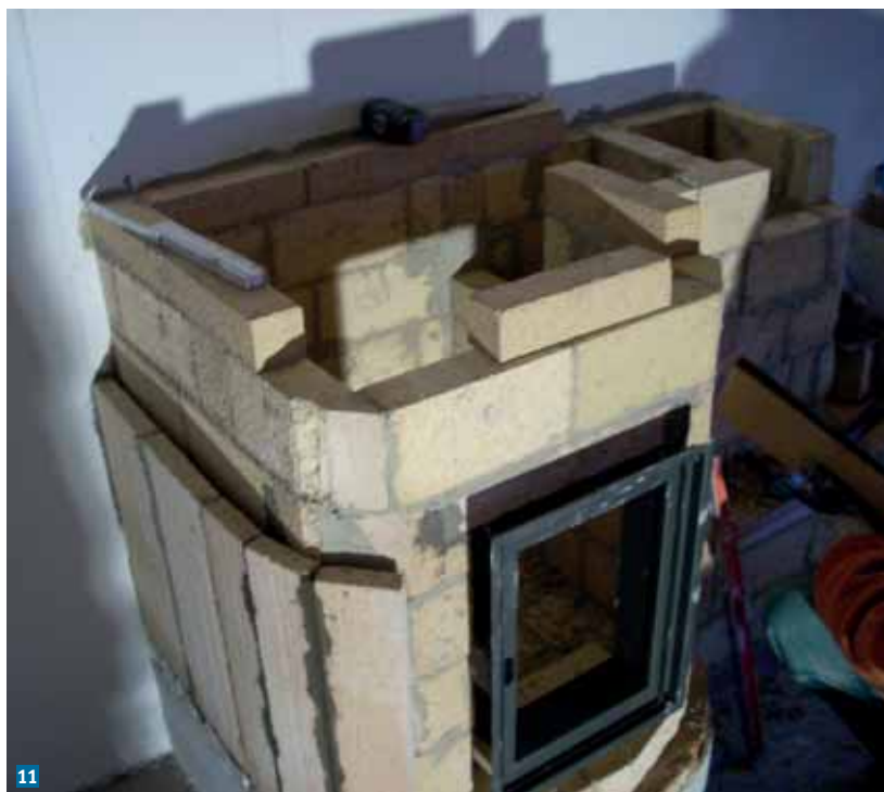
Stufa in costruzione: le fughe chiare fra i mattoni sono fatte con malta a base d'argilla, quelle più scure fra le tavelle sono in cemento refrattario.
