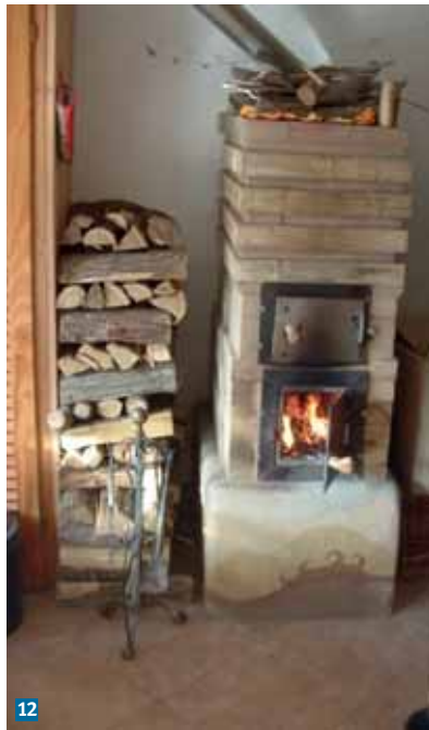
La «stufa russa» autocostruita con di fianco la legna sufficiente per 13 giorni.
